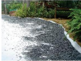
2. ลงด้วยหินเกล็ดหินคลุกบดอัดให้แน่น ประมาณ 7 ซม.
