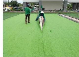
6. บริเวณขอบหญ้าใช้ตะปูคอนกรีตขนาด 3 นิ้วตอกยึด บริเวณแนวของหญ้าเทียมกับหญ้าเคลือบเมื่อติดตั้งเสร็จ ใช้แปรงพลาสติก แปรงย้อนเส้นใบหญ้าเพื่อให้ใบหญ้า ตั้งขึ้นสามารถใช้งานได้ตามปกติ
