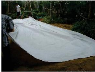
1. ขุดลอกหน้าดินเดิมออก 8 ซม. เพื่อกำจัดวัชพืช ปูรองพื้นด้วย Geotextile เพื่อกันวัชพืช
