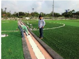
4-5. ปูหญ้าเทียมลงบนพื้นที่ ดึงให้ตึงเรียบ กรณีมีการต่อหญ้า ใช้แผ่นต่อหญ้าเป็นตัวเชื่อมระหว่างหญ้า 2 ผืน โดยหันแนว ในหญ้าเทียมไปในทิศทางเดียวกัน แล้วกดด้วยทาวเวอร์โรลเลอร์ 2 ส่วนผสมกันสำหรับต่อเชื่อมหญ้าเทียม 2 ผืน ทิ้งไว้กว่าแห้ง 15-20 นาที แล้วค่อยประกบหญ้า 2 ผืนเข้าด้วยกัน โดยวางให้ชิดอย่าให้แยกกัน และหันแนวหญ้าไปในทางเดียวกัน
