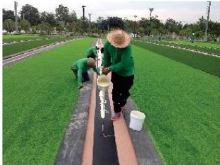
4-5. ปูหญ้าเทียมลงบนพื้นที่ ดึงให้ตึงเรียบ กรณีมีการต่อหญ้า ใช้แผ่นต่อหญ้าเป็นตัวเชื่อมระหว่างหญ้า 2 ผืน โดยหันแนว ในหญ้าเทียมไปในทิศทางเดียวกัน แล้วกดด้วยทาวเวอร์โรลเลอร์ 2 ส่วนผสมกันสำหรับต่อเชื่อมหญ้าเทียม 2 ผืน ทิ้งไว้กว่าแห้ง 15-20 นาที แล้วค่อยประกบหญ้า 2 ผืนเข้าด้วยกัน โดยวางให้ชิดอย่าให้แยกกัน และหันแนวหญ้าไปในทางเดียวกัน
